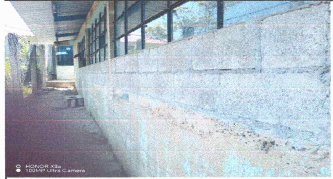
Foto 2: Repello de paredes interior y exterior
