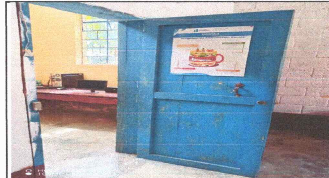
foto 4: sustitucion de puertas de madera por puertas de metal
